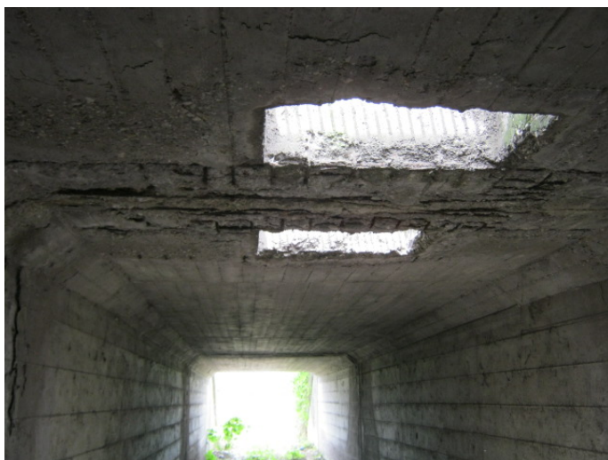
Ammaloramento giunto longitudinale
