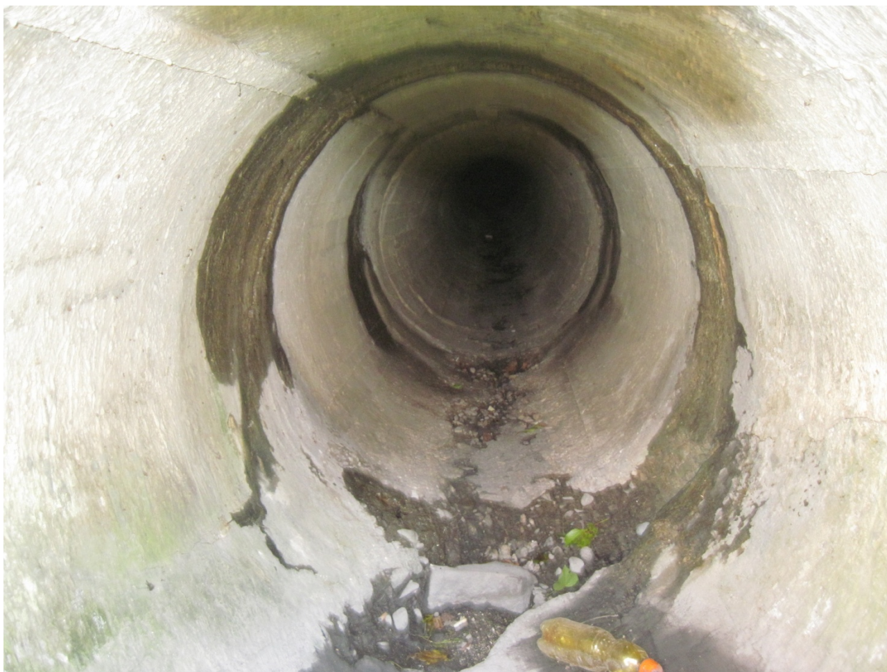
Opera con fondo danneggiato a causa del passaggio dell'acqua o di infiltrazioni di acque
