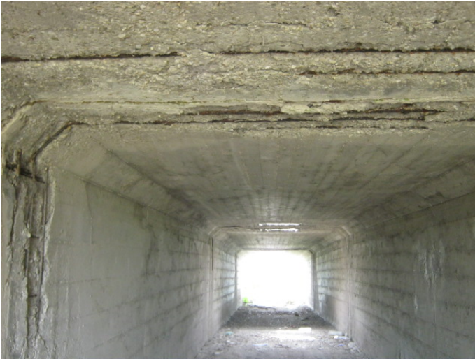
Ammaloramento imbocco
