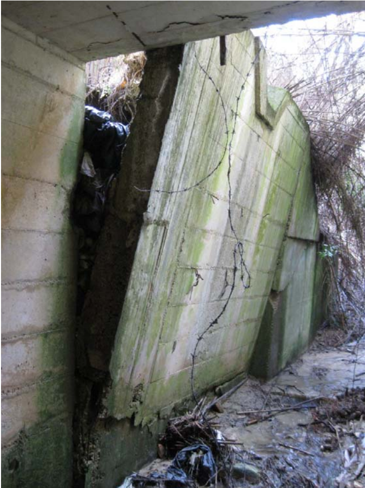
Cedimento del muro d'ala
