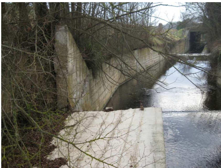
Cedimento del rivestimento di sponda
