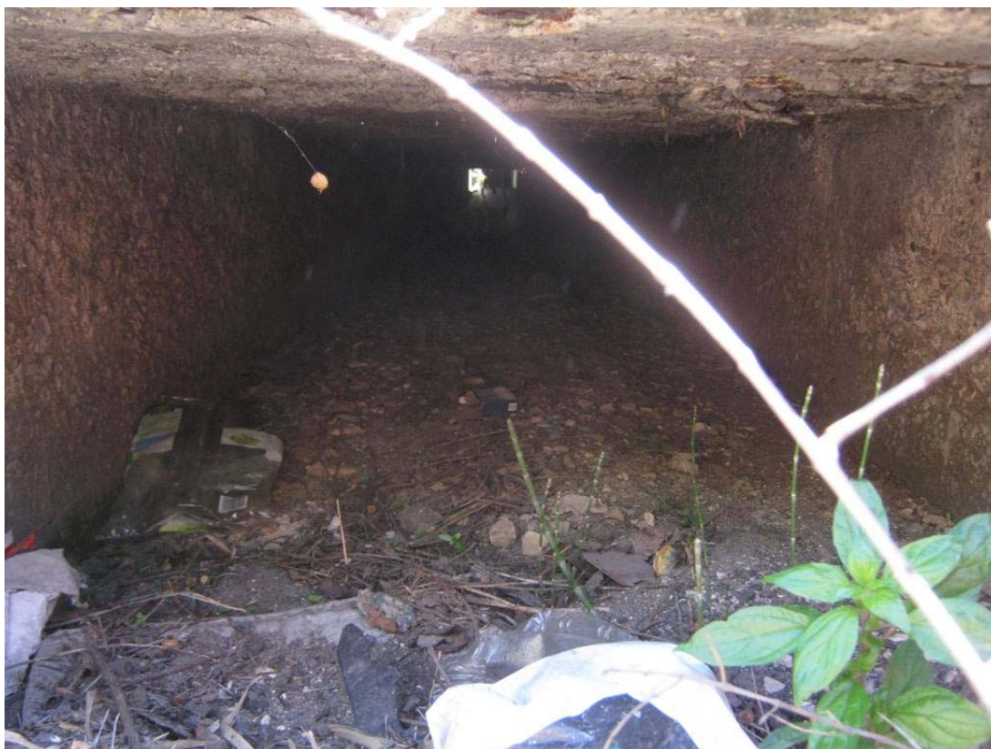
Presenza di detriti che riduce la funzionalità idraulica dell'opera
