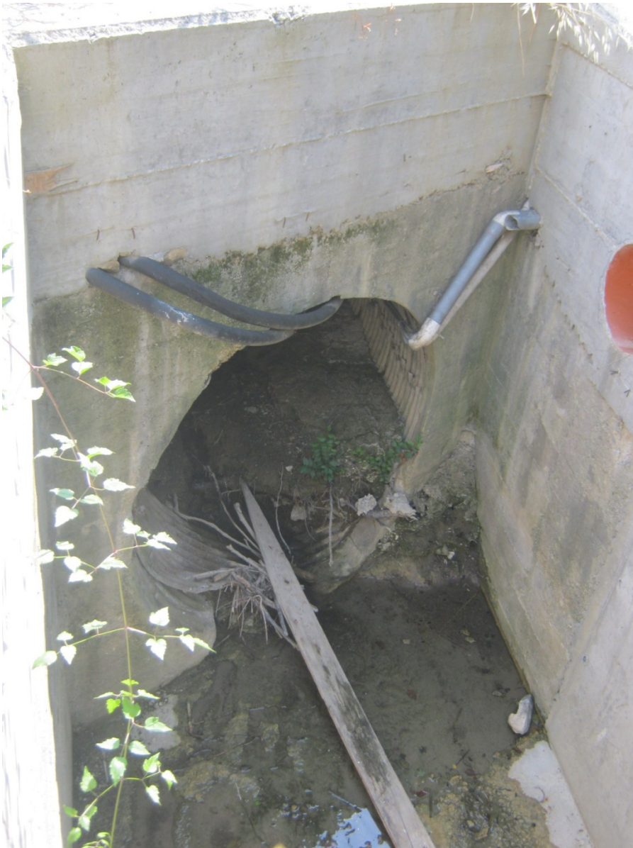
Intasamento che impedisce parzialmente il deflusso nella sezione
