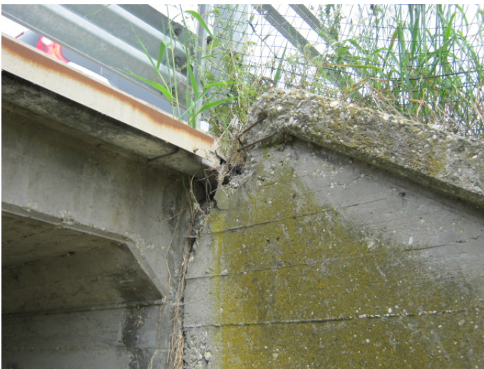
Ammaloramento muro d'ala
